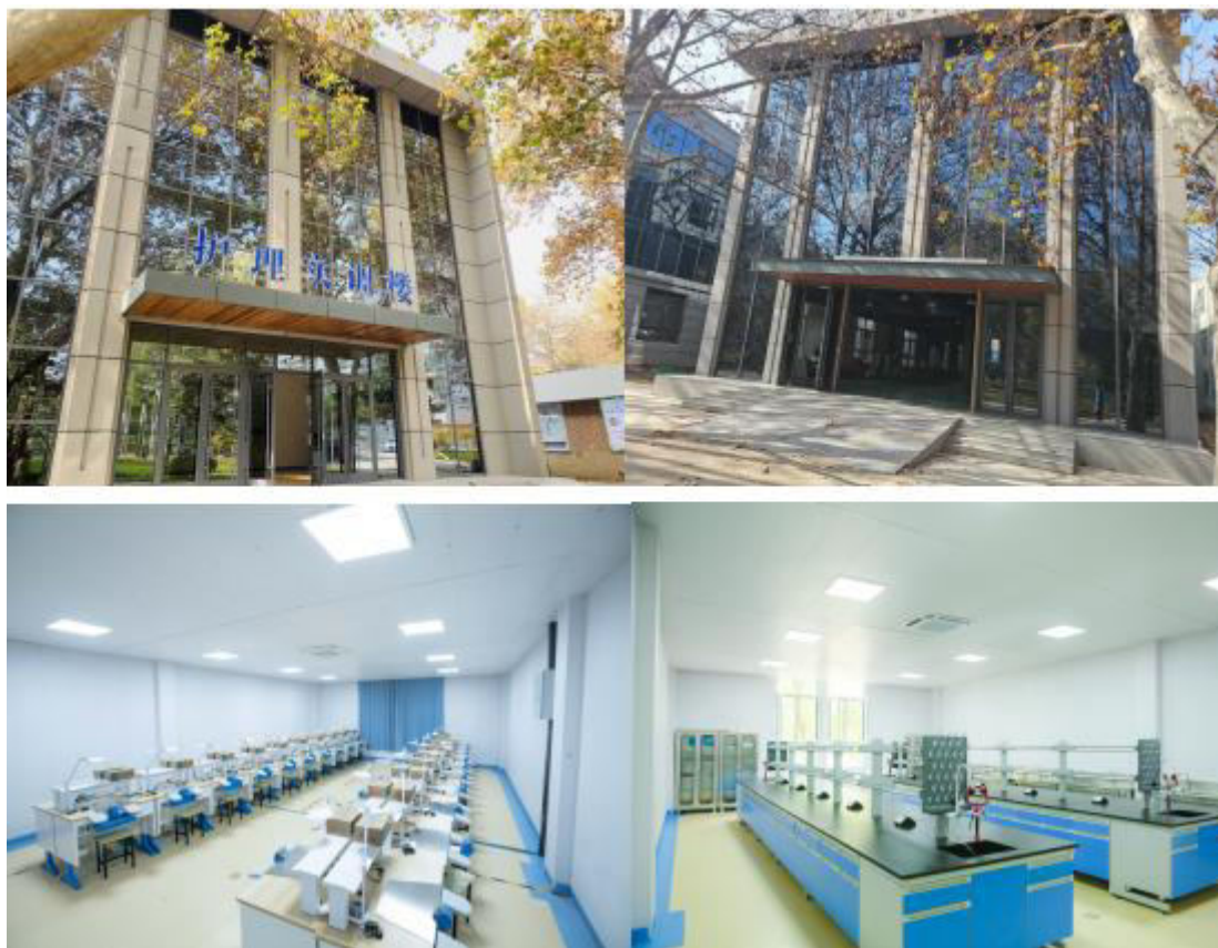
图 5-2 护理实训楼、智能工实训楼实景图
